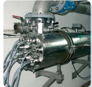
Abbildung F: UV-Reaktor mit konzentrisch angeordneten Strahlern
