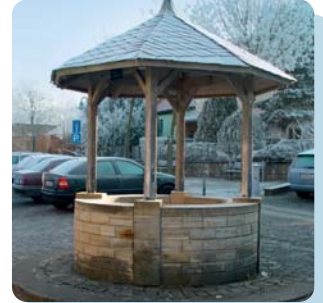
Abbildung D: gemauerter Schachtbrunnen
