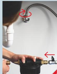
➤ Der zweite mitgelieferte Schlauch wird am Filtergehäuseausgang (»OUT«) mittels Schnellkupplung aufgesteckt, das andere Ende (Winkelstück) mit dem Schlauch, der zur Armatur führt, fest verschraubt.
