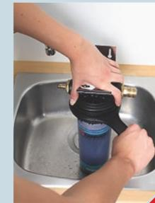
➤ Das Gehäuse wird in der Spüle geöffnet. Dazu den schwarzen Kunststoffring (Überwurfmutter) mit dem beigelegten Kunststoffschlüssel lockern, den unteren Teil des Gehäuses (Filtertasse) nach unten wegziehen und die gebrauchte Filterpatrone entfernen.
